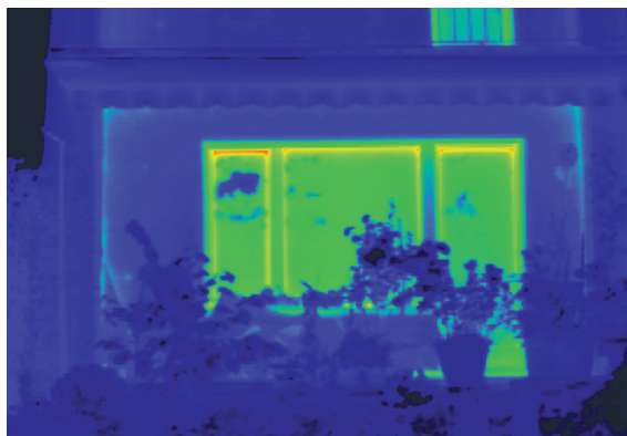
Μετά την προσεγμένη τοποθέτηση των νέων κουφωμάτων Corona CT 70, το θερμογράφημα αποδεικνύει το υψηλό ενεργειακό όφελος (σύγκριση με διπλανή φωτογραφία). Η αρχική απώλεια ενέργειας έχει αποτραπεί σχεδόν τελείως.
