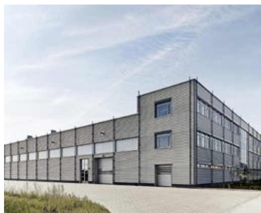
Neue Kaschierhalle am Standort der Schüco Polymer Technologies KG New foiling hall at the Schüco Polymer Technologies KG site
