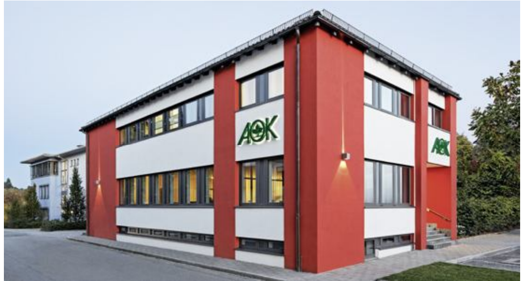
Bürogebäude, Landau, Deutschland Office building, Landau, Germany
